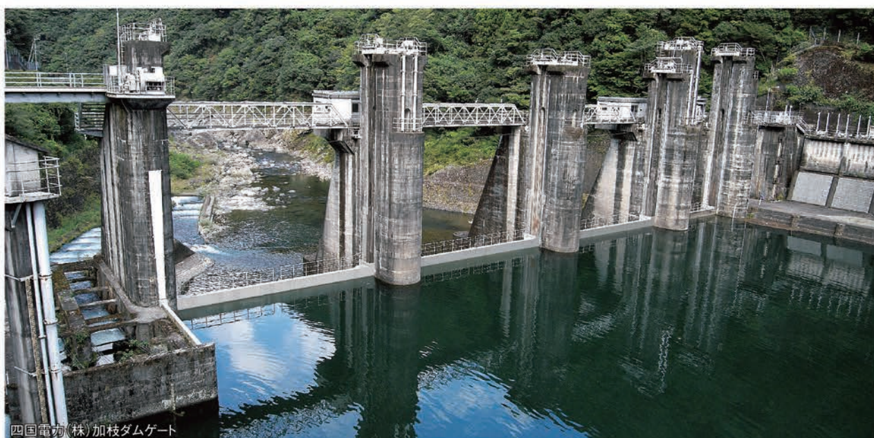
四国電力(株)加枝ダムゲート
