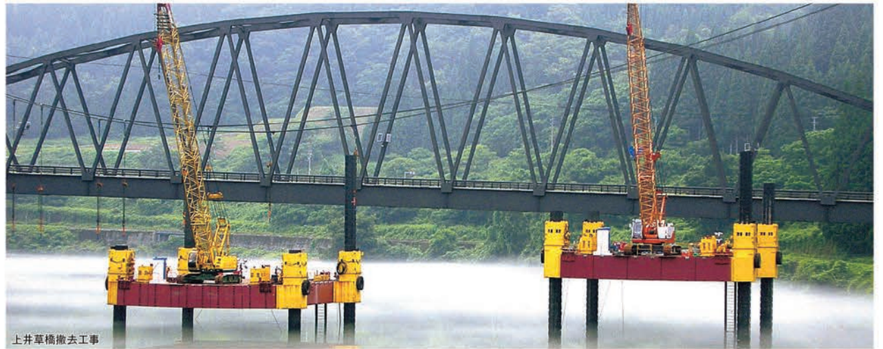
上井草橋撤去工事
