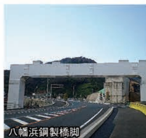
八幡浜鋼製橋脚
